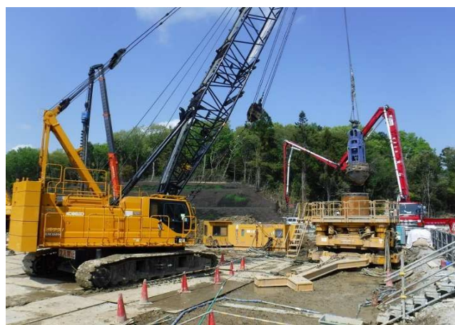
地盤改良工事(柱状改良)
