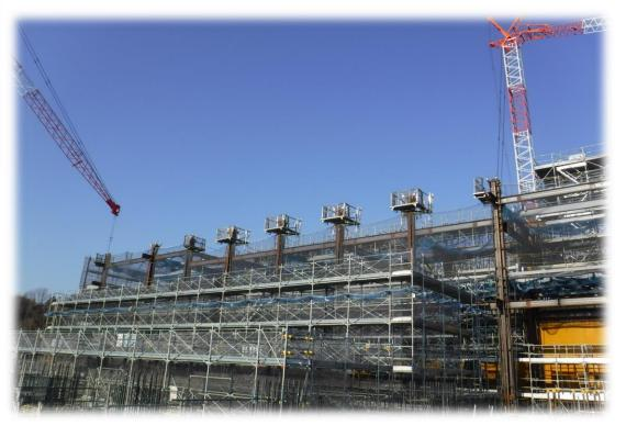
●工場棟(炉室)の鉄骨工事が進んでいます。
