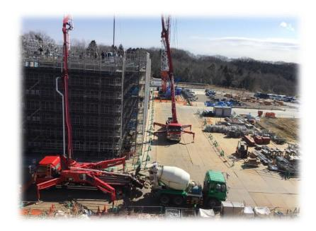
●工場棟3階床基礎コンクリートを打設しています。
