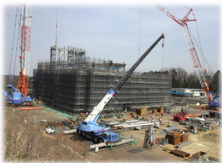
●炉室4階5階の鉄骨工を行っています。
