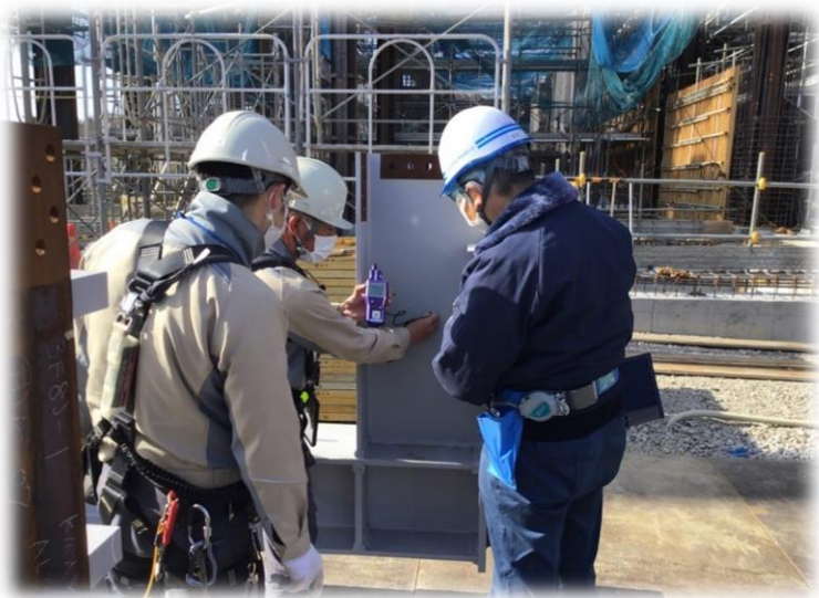
●鉄骨塗装の膜厚検査を行っています。
