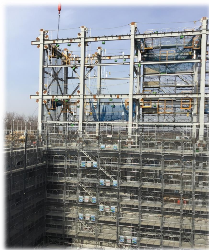
●炉室4階5階の鉄骨工を行っています。 (炉室内側より)
