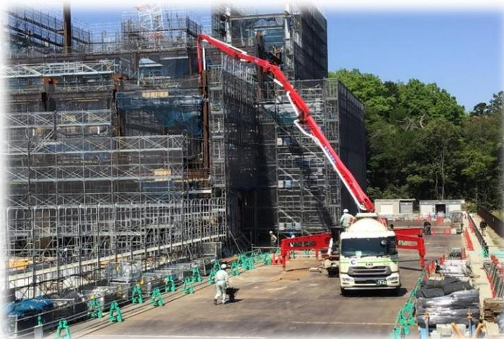
● ごみピット 1階コンクリート打設状況
