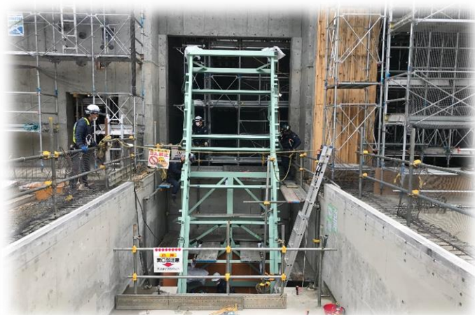
● 搬送装置フレームの設置状況
