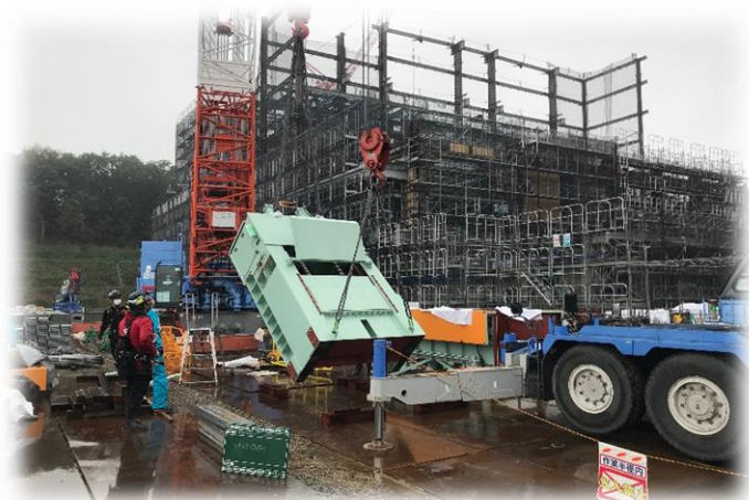
● 可燃性粗大ごみ破碎机据付中
