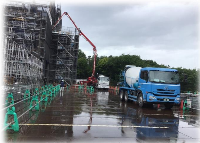
●1工区3階床コンクリート打設状況
