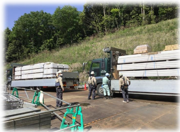
●ALC版受入検査状況
