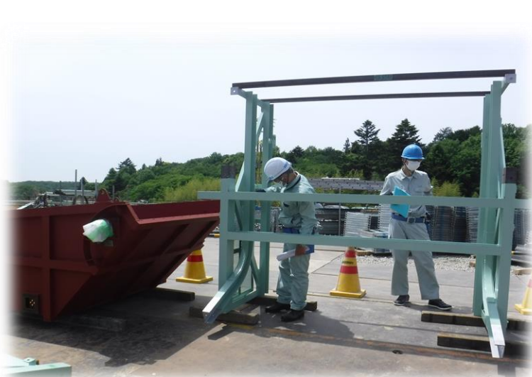
● 破碎ごみ搬送装置受入検査状況
