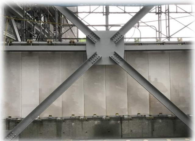
●炉室3階外壁ALC版取付状況
