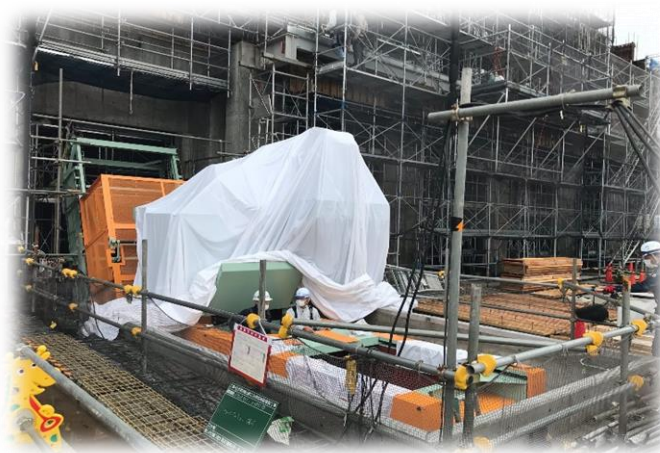
● 搬送装置、破碎机設置完了
