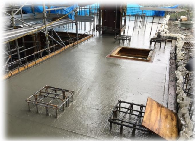
●1工区3階床コンクリート施工状況
