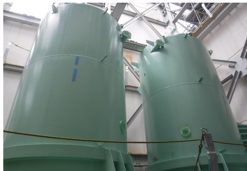
●1工区薬剤供給装置貯槽取り込み状況
