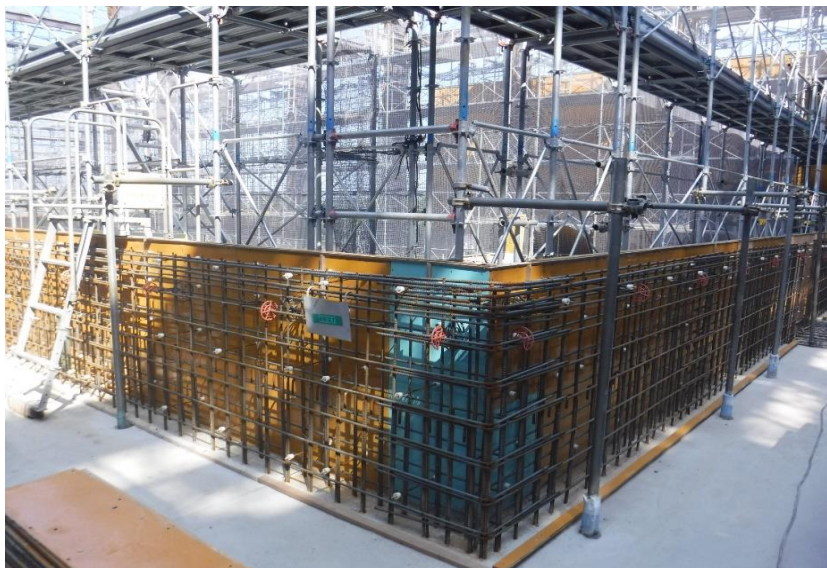
●2工区ごみピット廻り配筋工事状況
