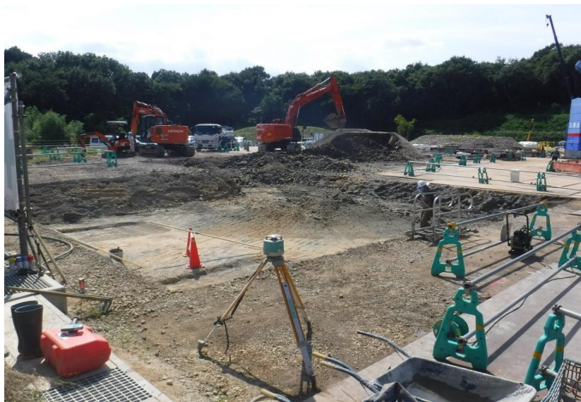
●管理棟エリア掘削工事状況
