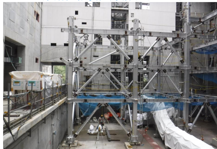
●1工区プラント鉄骨組立作業状況
