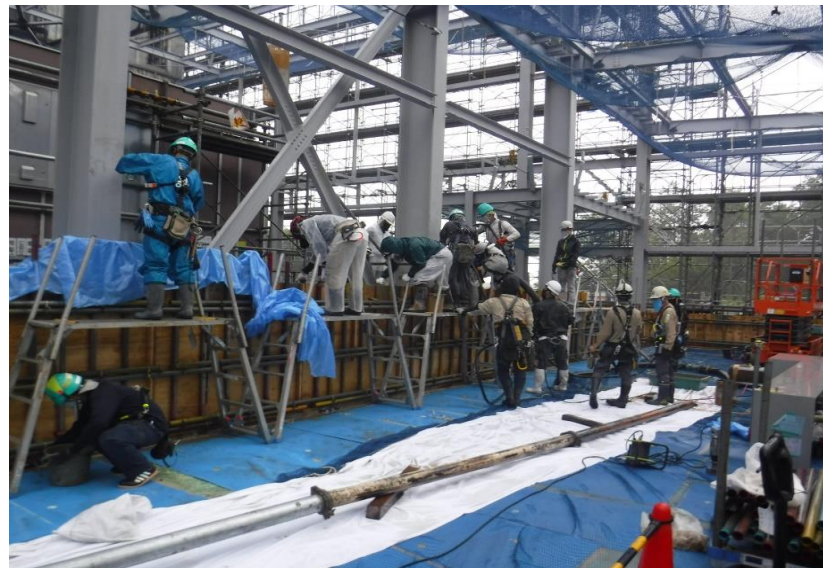
●3工区腰壁コンクリート打設状況
