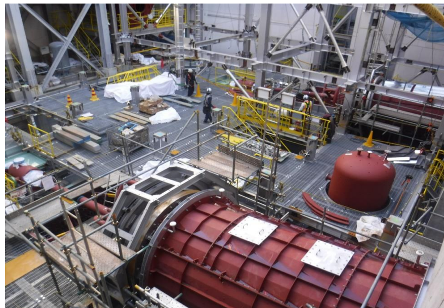
●1工区炉室内機器据付状況
