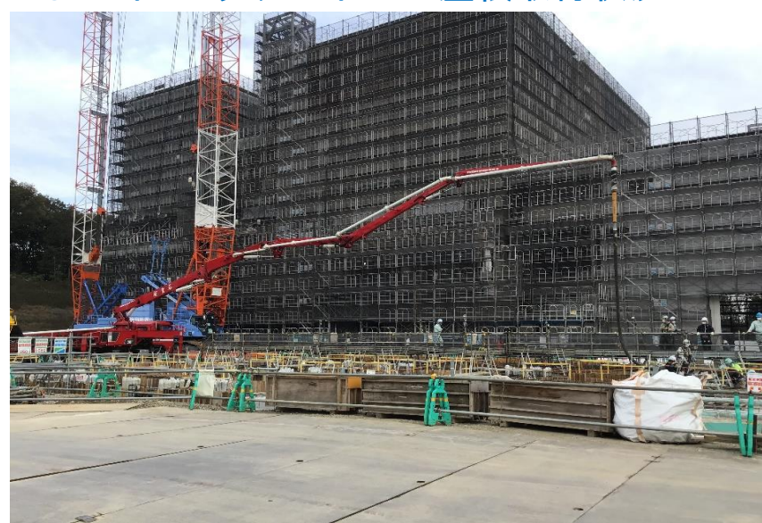
●管理棟基礎コンクリート打設状況
