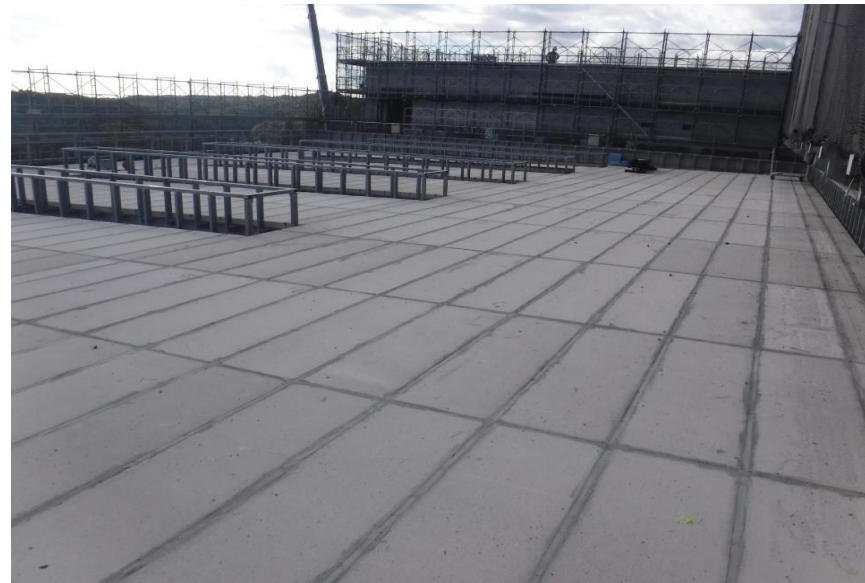
●3工区プラットホーム屋根取付状況
