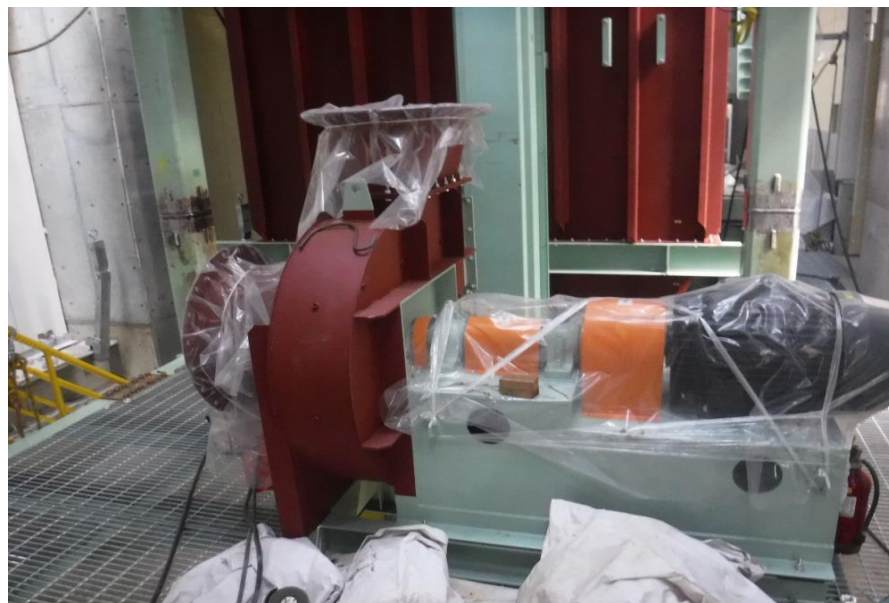
●1工区環境集じんファン設置状況
