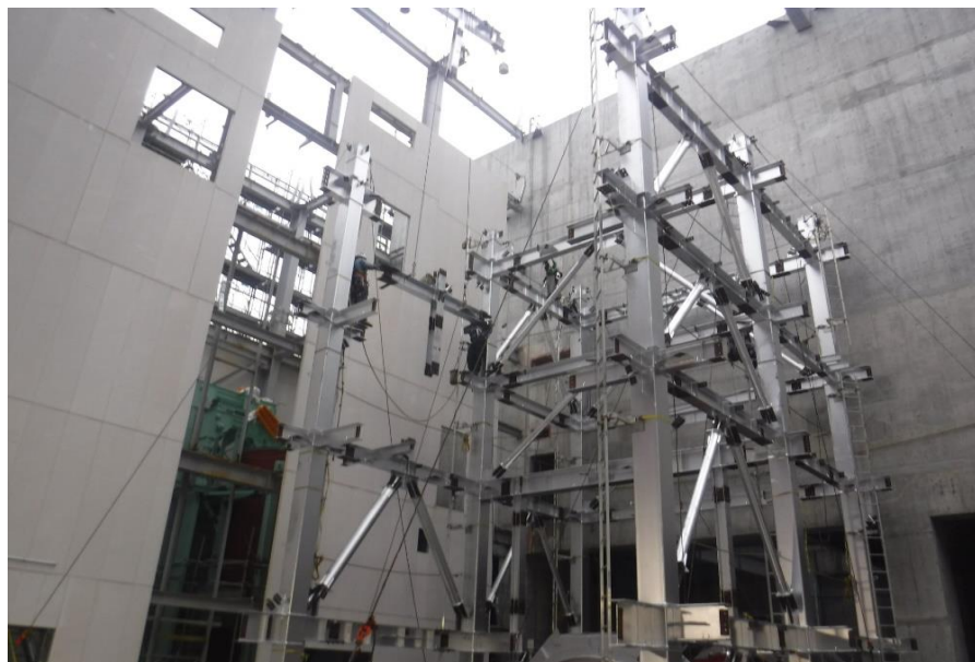
●1工区プラント炉架構4～5階部分建方開始
