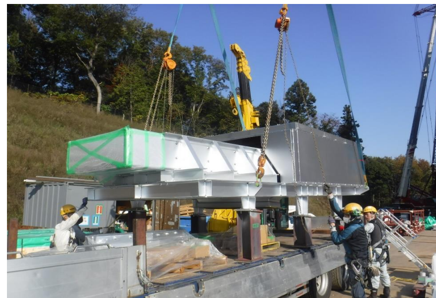
●工場棟西エリア給じん装置搬入状況
