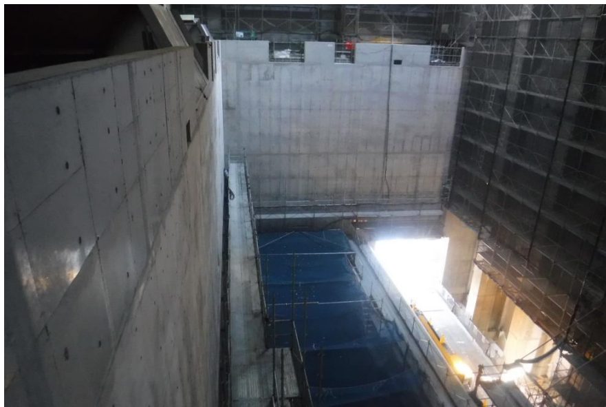
●2工区ごみピット足場解体状況
