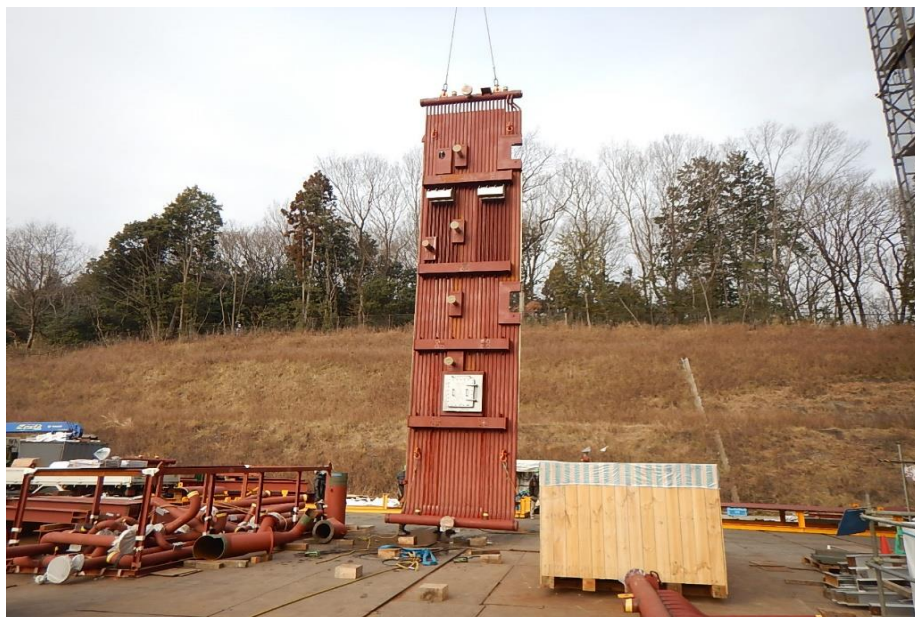
●1工区ボイラ水管壁パネル吊り上げ状況
