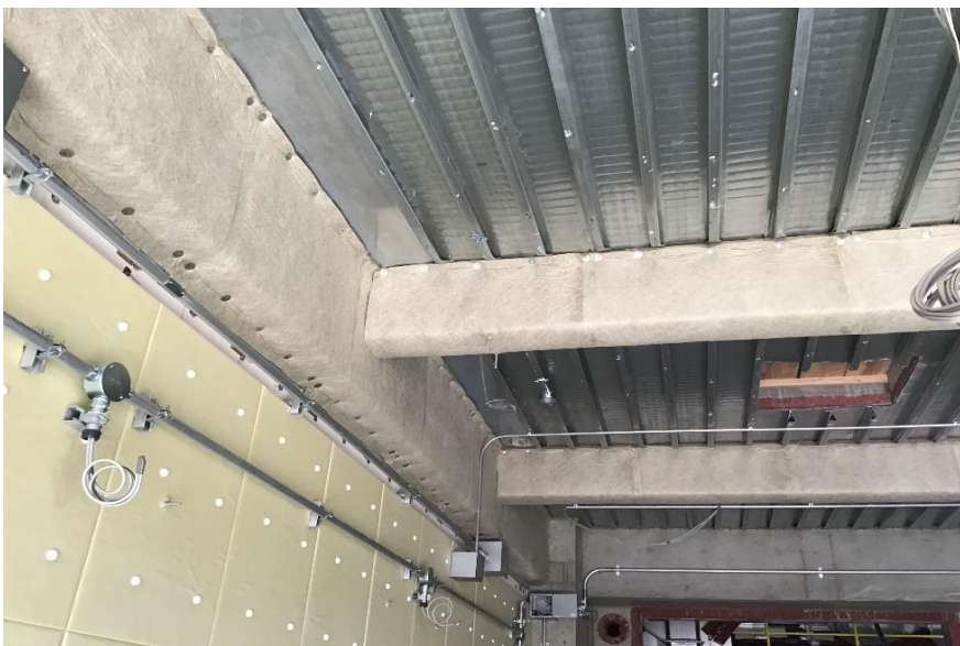
●工場棟内各所耐火被覆取付状況
