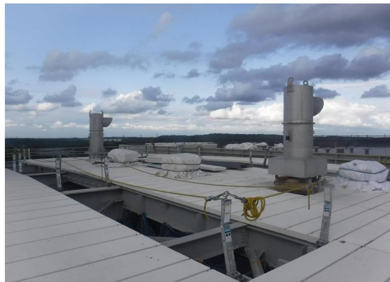
●1工区炉室天井部ボイラ安全弁用消音器設置状況
