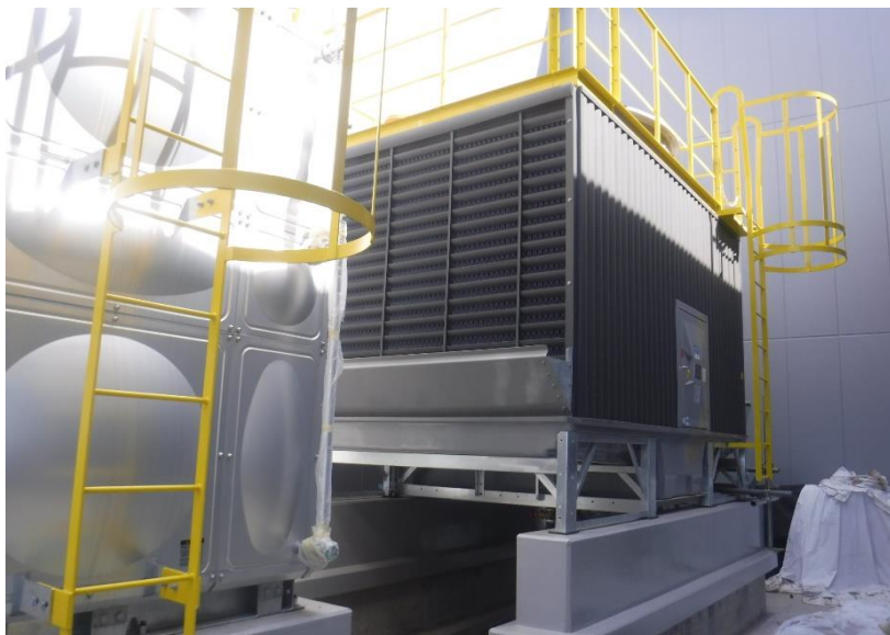
●1工区機器冷却水冷却塔設置状況
