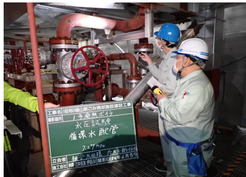
●1工区炉室ボイラ水圧試験実施状況
