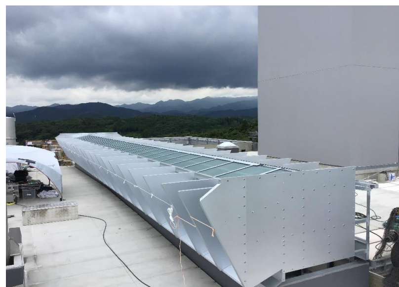
●1工区炉室屋根ベンチレーター施工状況
