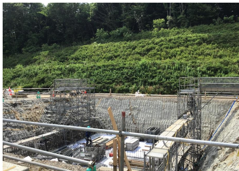
●計量棟基礎部施工状況
