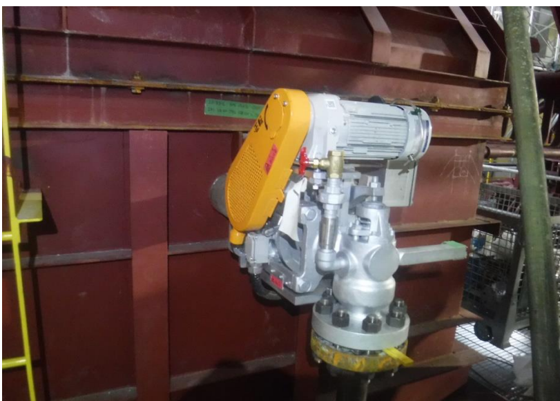
●1工区ボイラスーフトブロワ設置状況
