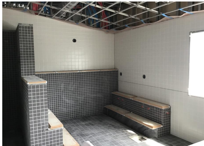
●2工区3階浴室タイル貼り状況
