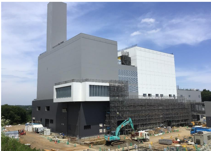
●1工区工場棟外部足場解体状況
