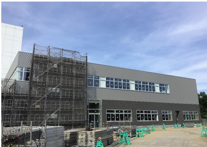
●管理棟外部足場解体状況
