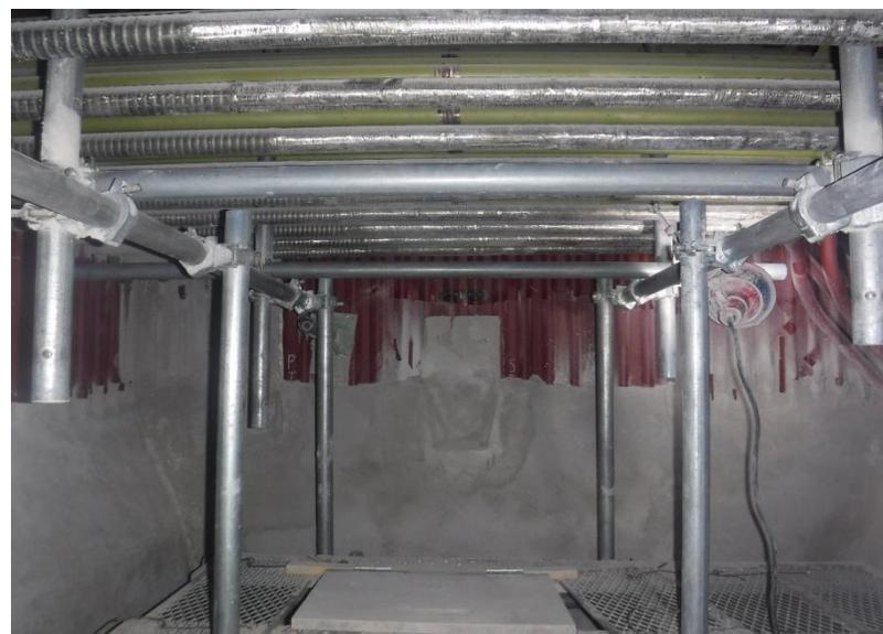
●1工区 ボイラ内部耐火材施工状況
