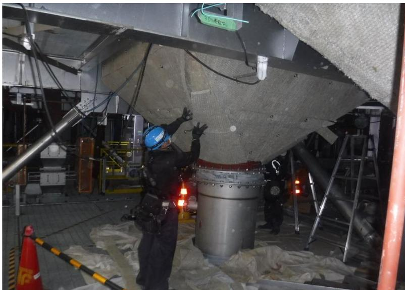
●1工区 脱硝反応塔ホッパ保温施工状況
