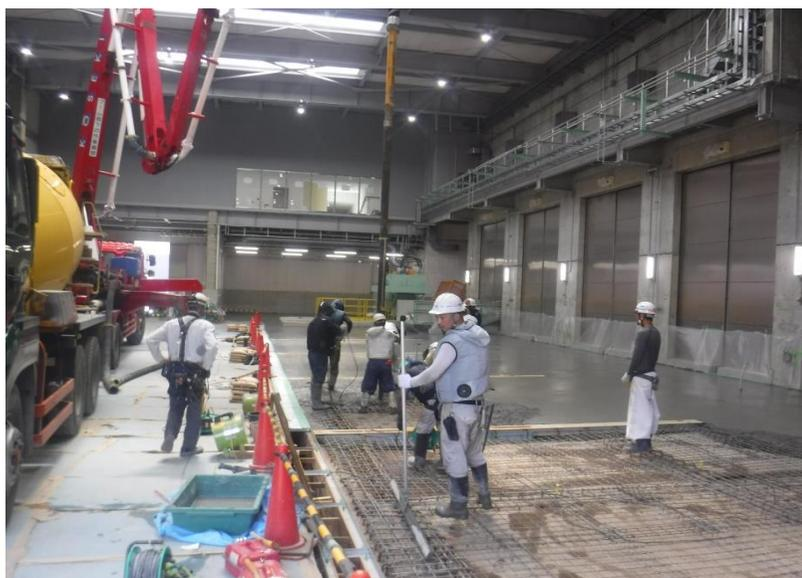
●3工区 プラットホーム床コンクリート施工状況
