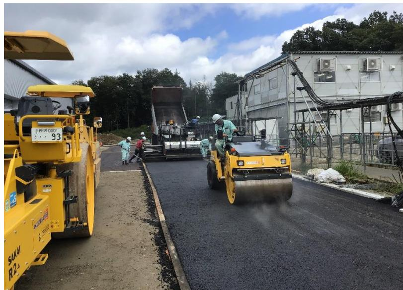
●外構 舗装(基層)施工状況
